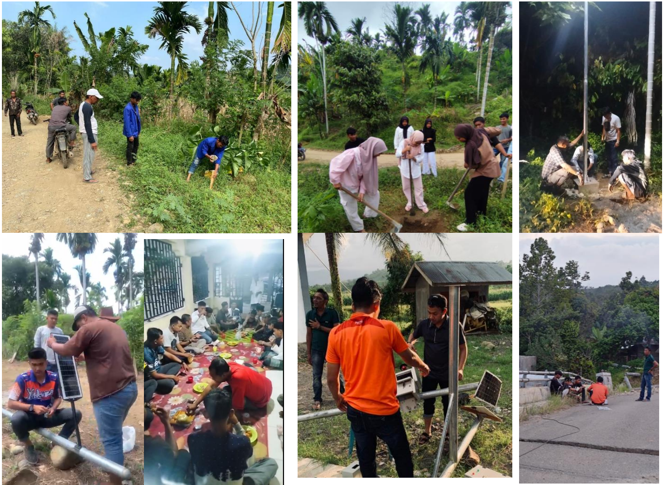
Gambar 4. Instalasi Lampu Jalan Solar Cell dan EWS (Sumber: Dokumentasi Tim, 2026)
