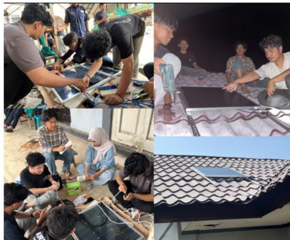
Gambar 6. Proses instalasi Pembangkit Listrik Tenaga Surya mini di Meunasah Desa Dayah Leubu, Kecamatan Ulim, Pidie Jaya
