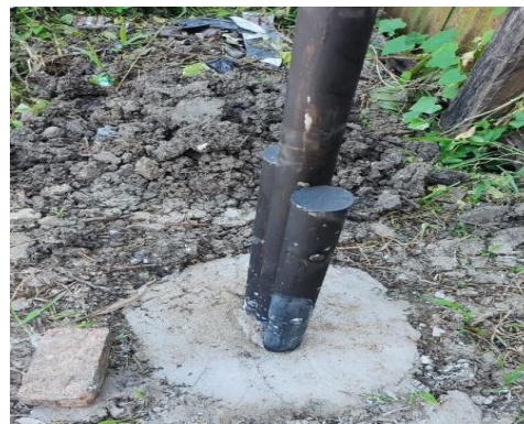
Gambar 7. Pemasangan tiang lampu jalan
