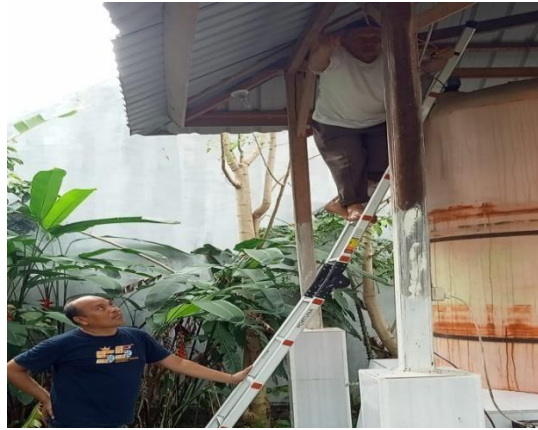
Gambar 1. Observasi Instalasi Pompa
