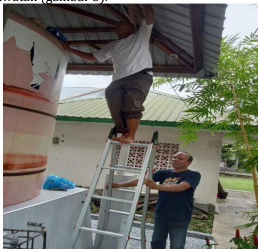
Gambar 3. Perbaikan Instalasi Kelistrikan
