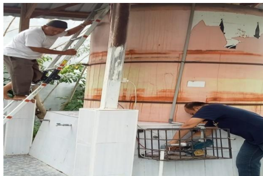
Gambar 2. Sasaran komponen akan di perbaikan
